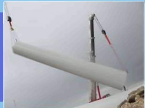
En el lado de la grúa de elevación se colocan 4 aros de carga especiales RUD, fijados a la brida del sector tubular y conectando éstos mediante grilletes especiales a 2 poleas de cable con capacidad para 35 toneladas suspendidas de la grúa, aseguramos que cada uno de los 4 aros de carga esté sometido a la misma tensión, admitiendo una carga de 18 toneladas por aro y por lo tanto, alcanzamos una capacidad de elevación en conjunto de 70 toneladas.
