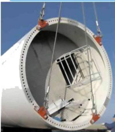
En el lado de la grúa de retenida se colocan 2 aros de carga especiales RUD, fijados a la brida del sector tubular y conectando éstos mediante grilletes especiales a una eslinga de 2 ramales VIP de 0 22 mm suspendida de la grúa.
