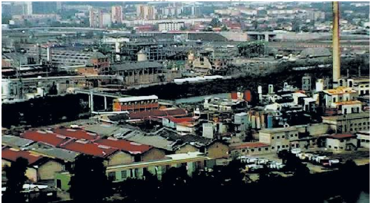
Vista general de la fábrica después de la explosión.
