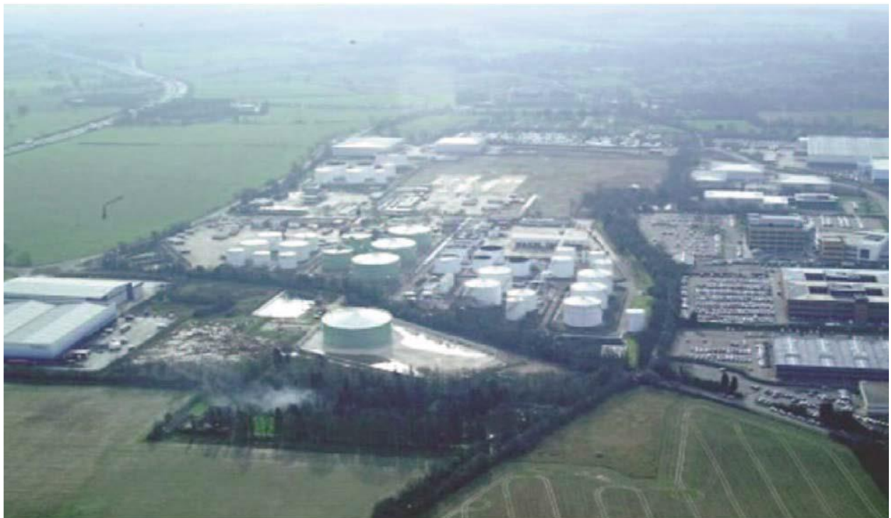
Figura 1: Vista aérea del depósito de Buncefield antes del incidente. (Buncefield Major Incident Investigation Board, 2008b)
