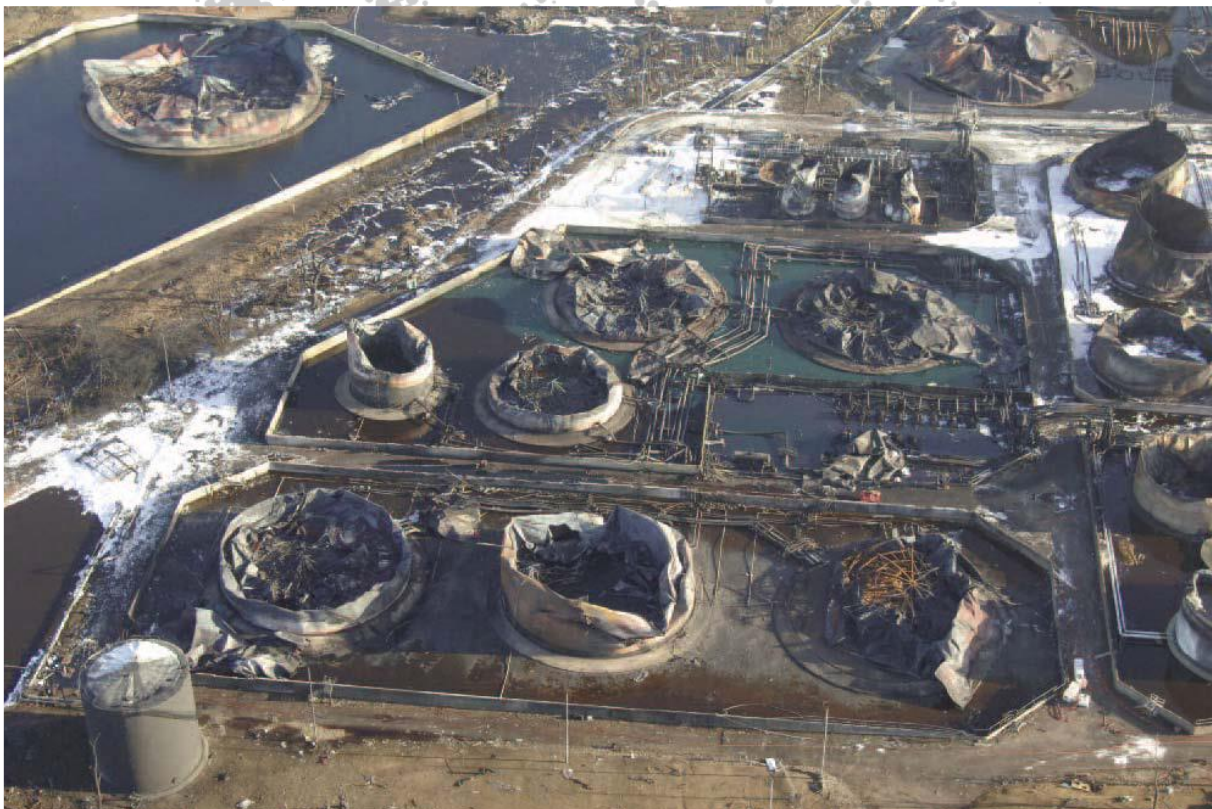
Figura 10: Destrucción causada por el incendio y las fuertes presiones debido a las explosiones (Buncefield Major Incident Investigation Board, 2006a).
