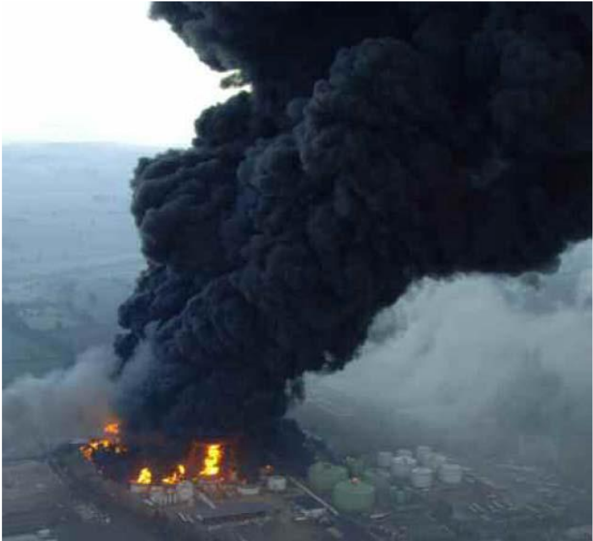
Figura 4: Depósito de Buncefield durante el incendio. (Buncefield Major Incident Investigation Board, 2008b).
