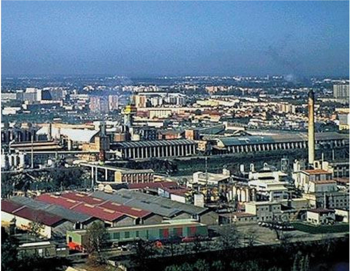
Vista general de la fábrica antes de la explosión.
